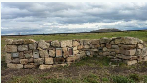
Muret en pierres sèches (ici avec des gîtes intégrés)...
